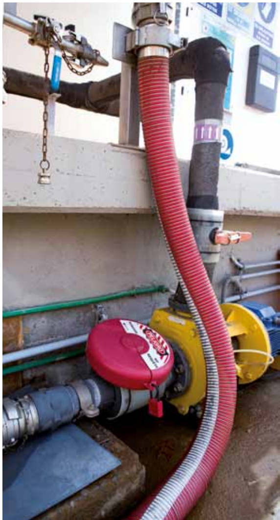
MILLORES EN SEGURETAT D'esquerra a dreta: codi QR al casc d'un treballador; accés d'escala protegit; mecanisme LOTOC per bloquejar quadres elèctrics; un operari fa servir un imant en U, eina ergonòmica que facilita l'aixecament de tapes i plaques, tot evitant lesions.
