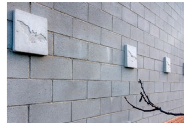
Refugi per a ratpenats a l'ETAP de Sant Joan Despi.
